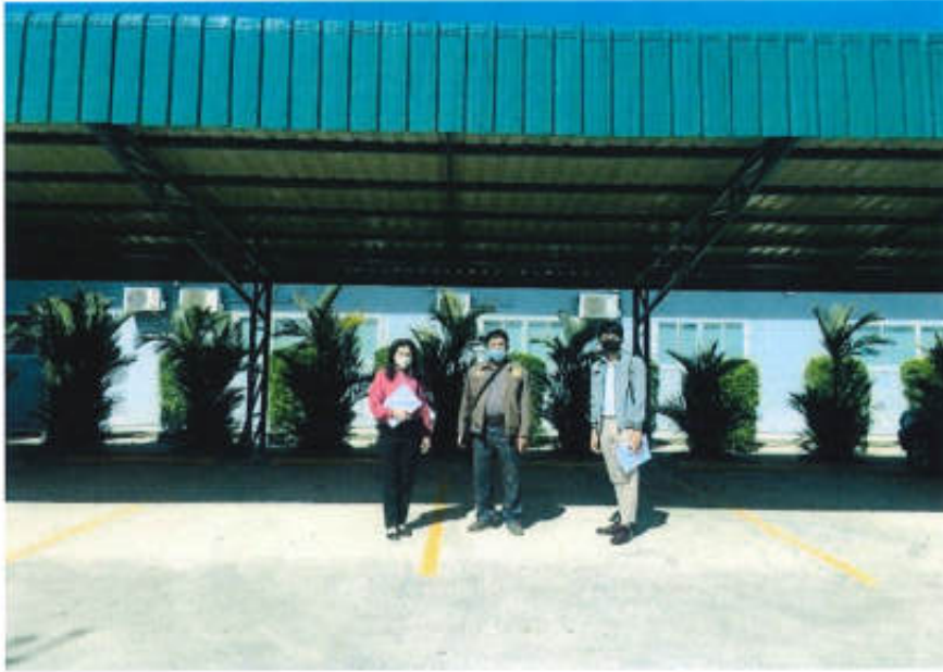
อุดหนุนสำนักงานคณะกรรมการอิสลามประจำจังหวัดชลบุรี ตำบลตะเคียนเตี้ย อำเภอบางละมุง โครงการก่อสร้างหลังคาสำนักงานคณะกรรมการอิสลามประจำจังหวัดชลบุรี งบประมาณ 1,000,000 บาท โครงการดำเนินการแล้วเสร็จ
