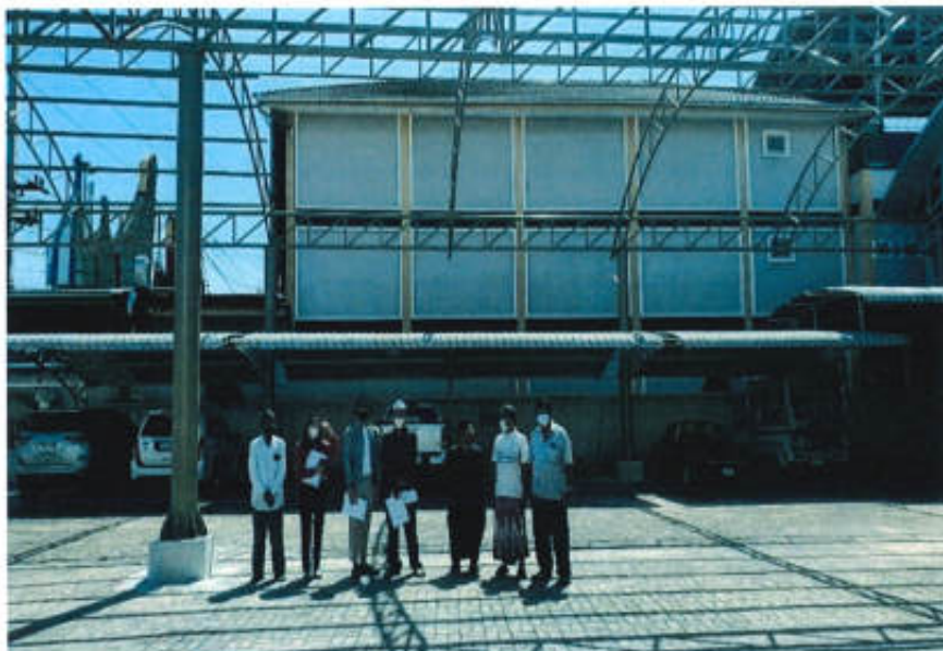
อุดหนุนมัস্যิดฮิดายัตุสซาลีเกีน ตำบลนาเกลือ อำเภอบางละมุง โครงการก่อสร้างหลังคาคลุมอเนกประสงค์ฯ งบประมาณ 500,000 บาท โครงการดำเนินการแล้วเสร็จ
